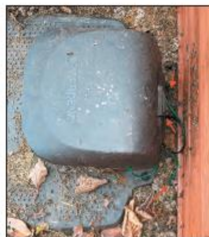
Bild 5. Die Ladestation im (geöffneten) Hundehäuschen mit angeschlossenen Kabeln.
