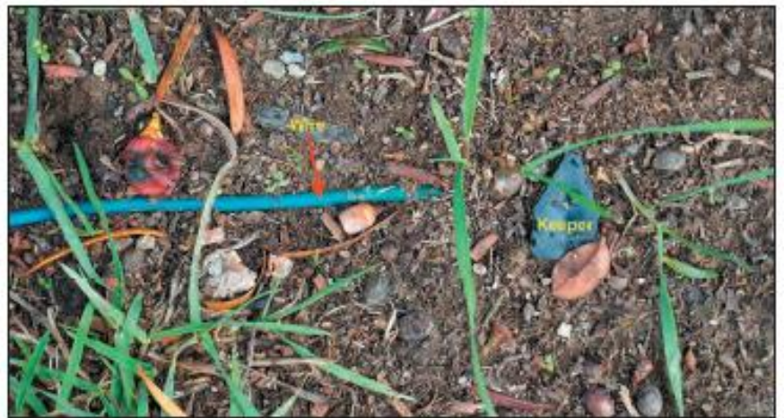
Bild 3. Die Leitung wurde hier mit Plastikheringen auf dem Rasen verlegt.
